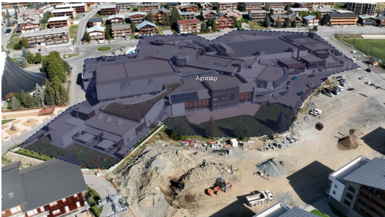
Figure 5 Photo du site de l'Agoralp. Source : ETUDE DE FAISABILITE ET DE PROGRAMMATION EN VUE DE LA CREATION D'UN COMPLEXE PISCINE – PATINOIRE SUR LE SITE DU PALAIS DES SPORTS ; Gécât, Session Pro, CET ; 21 décembre 2023
