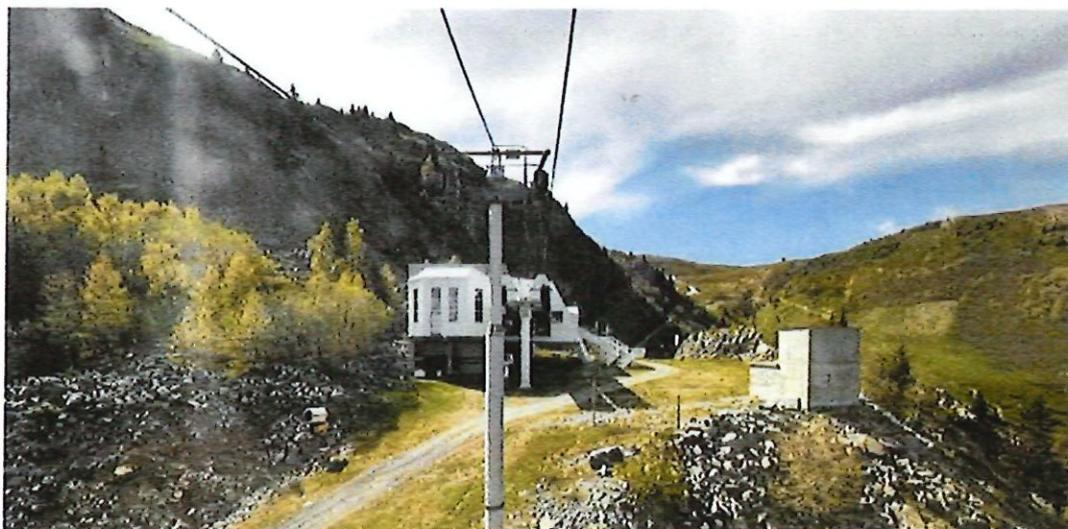
La nouvelle gare sera implantée au droit de la station existante. Le niveau d'embarquement de la nouvelle station se situera au sol.
