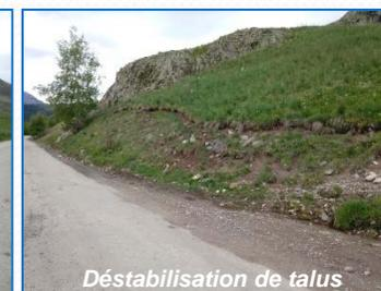
On note que malgré les travaux récents, il n'y a pas d'ouvrage de collecte suffisant au bas de la piste. On constate également que l'enrochement mis en œuvre pour stabiliser le talus, en contrebas de la chaussée, est susceptible d'écraser les canalisations en place (voir photo ci-contre).
