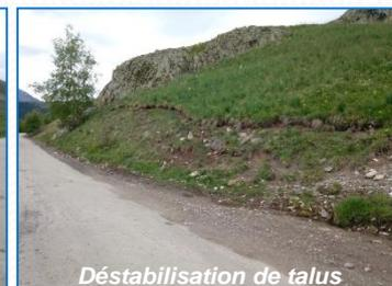
On note que malgré les travaux récents, il n'y a pas d'ouvrage de collecte suffisant au bas de la piste. On constate également que l'enrochement mis en œuvre pour stabiliser le talus, en contrebas de la chaussée, est susceptible d'écraser les canalisations en place (voir photo ci-contre).
