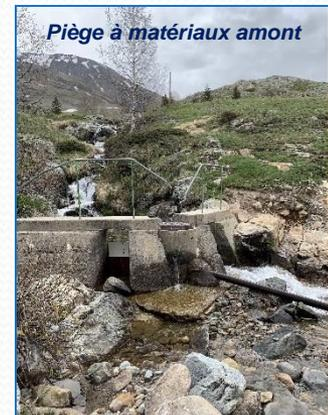
**=> Une surveillance et un entretien régulier du piège à matériaux amont et de l’ouvrage de franchissement de la piste de ski sont réalisés.**
