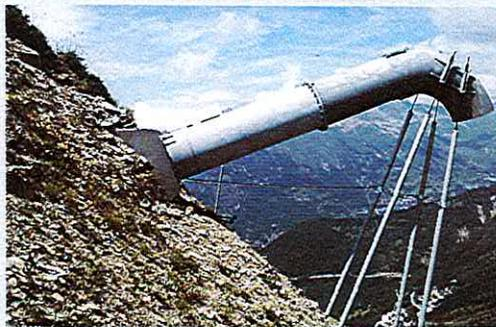
Situé au-dessus de la piste de Poutran, cet explodeur gazex utilise des gaz détonants pour déclencher des avalanches.
