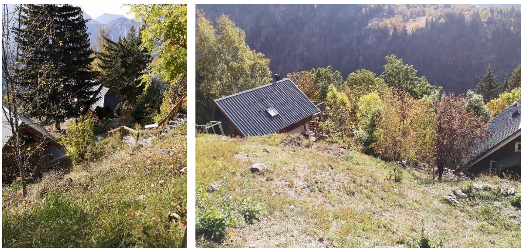
Vue des constructions concernées.
