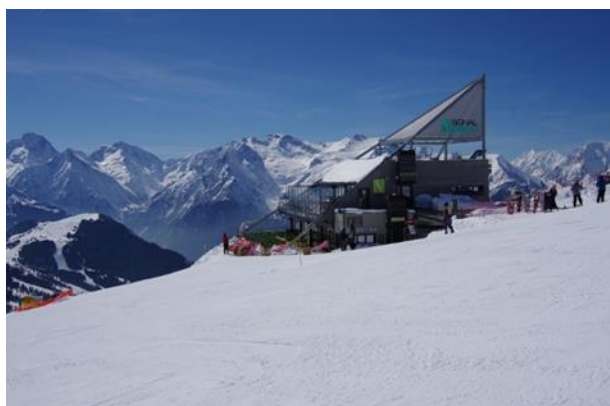
La gare d'arrivée du téléski de la Grande Sure, au signal, 2100 m. Source : Typicité.
