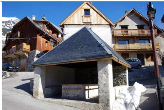
Le lavoir, patrimoine réhabilité. Source : Typicité.
