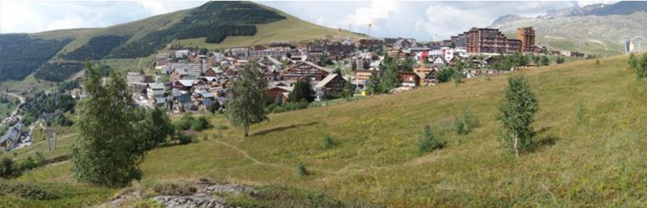
Vue du secteur centre de la zone. Source SYMBIOSE, aout 2018.
