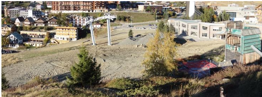
Vue du secteur de travaux du TCSP. Source SYMBIOSE, octobre 2018.
