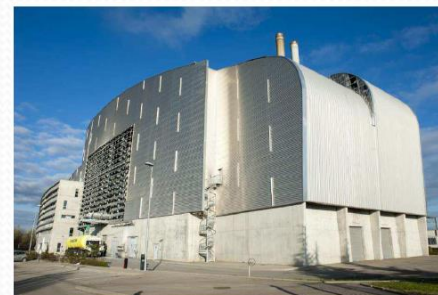
Usine de Valorisation Energétique SITOM Nord-Isère (RA 2016 – SITOM NI)
