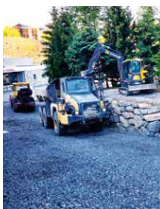
Sécurisation de la voie d'accès à la crèche
