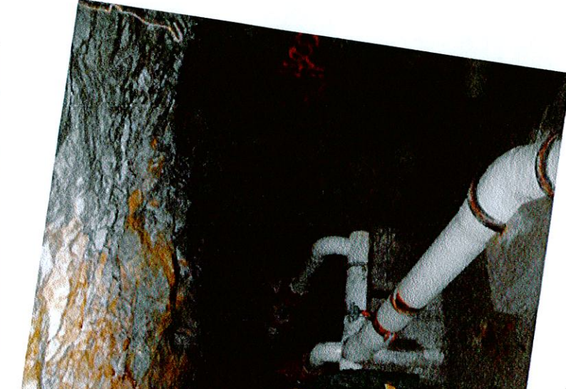
CHAMBRE SOUTERRAINE DES 7 TETES DE FORAGE
