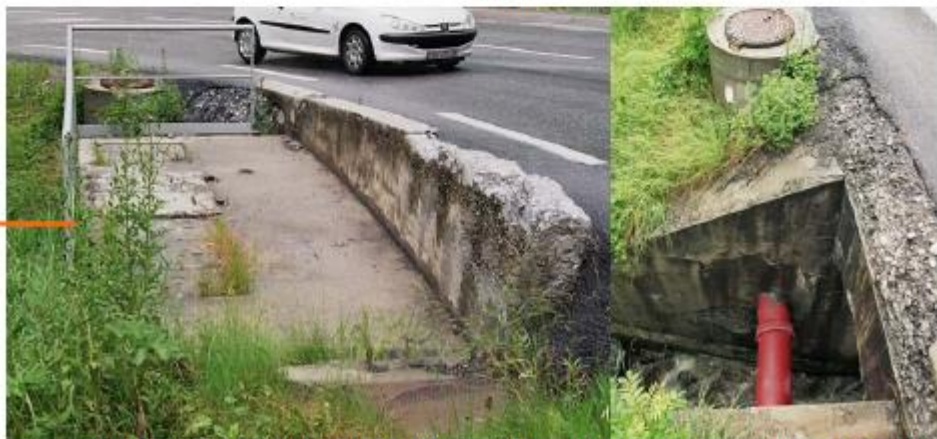
Dessableur / déversoir d'orage de l'entrée du village avec ses deux regards encadrant le tuyau de sortie Ø 300 - 350 connectant le réseau d'assainissement d'Huez au collecteur SACO
