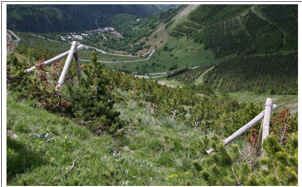
Photo 2 Association de tripodes bois et de plantations dans la zone de départ principale de l'avalanche CLPA n° 10
