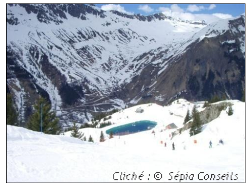
Photo 5 : Retenue de Montfrais
